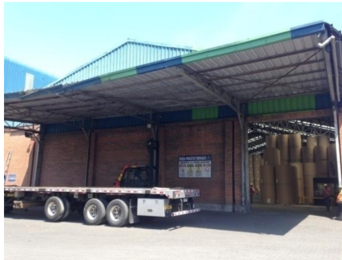
Figura 1: Fachada Bodega de Productos Terminados FPC S.A.
