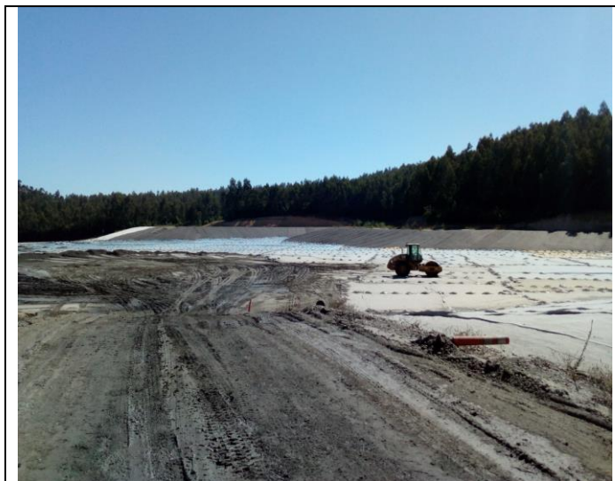
Figura 5. Cancha de acopio residuos termoeléctrica.
