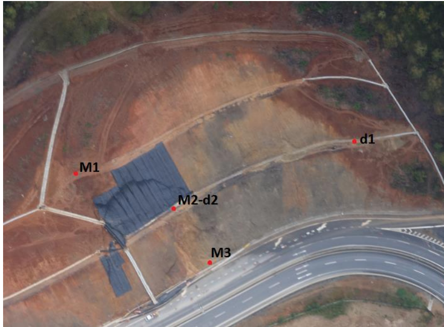
Figura 3.5: Ubicación de extracción de muestras del talud para ensayos de laboratorio. (Fuente: Elaboración propia).
