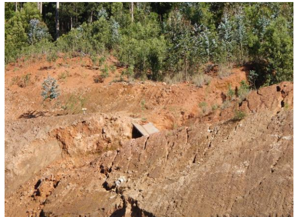
Figura 7.2: Colapso de talud ubicado en Chivilingo, toma lateral (fuente: Elaboración propia)
