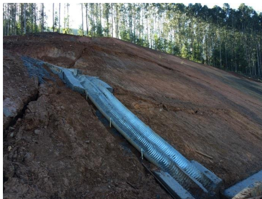
Figura 1.5: Grietas en talud. (Fuente: CONCESIONARIA RUTA 160 – Evaluación talud Dm 40+000 – 40+400; Informe Técnico).
