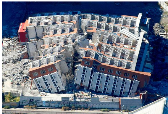
Figura 1: Derrumbe de edificio alto río. Fuente: Diario el Mercurio, 2010.
