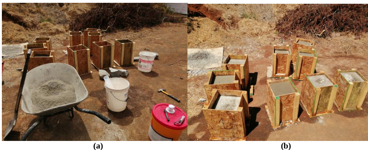
Figura 4.4 Proceso de construcción de bloques de hormigón.
