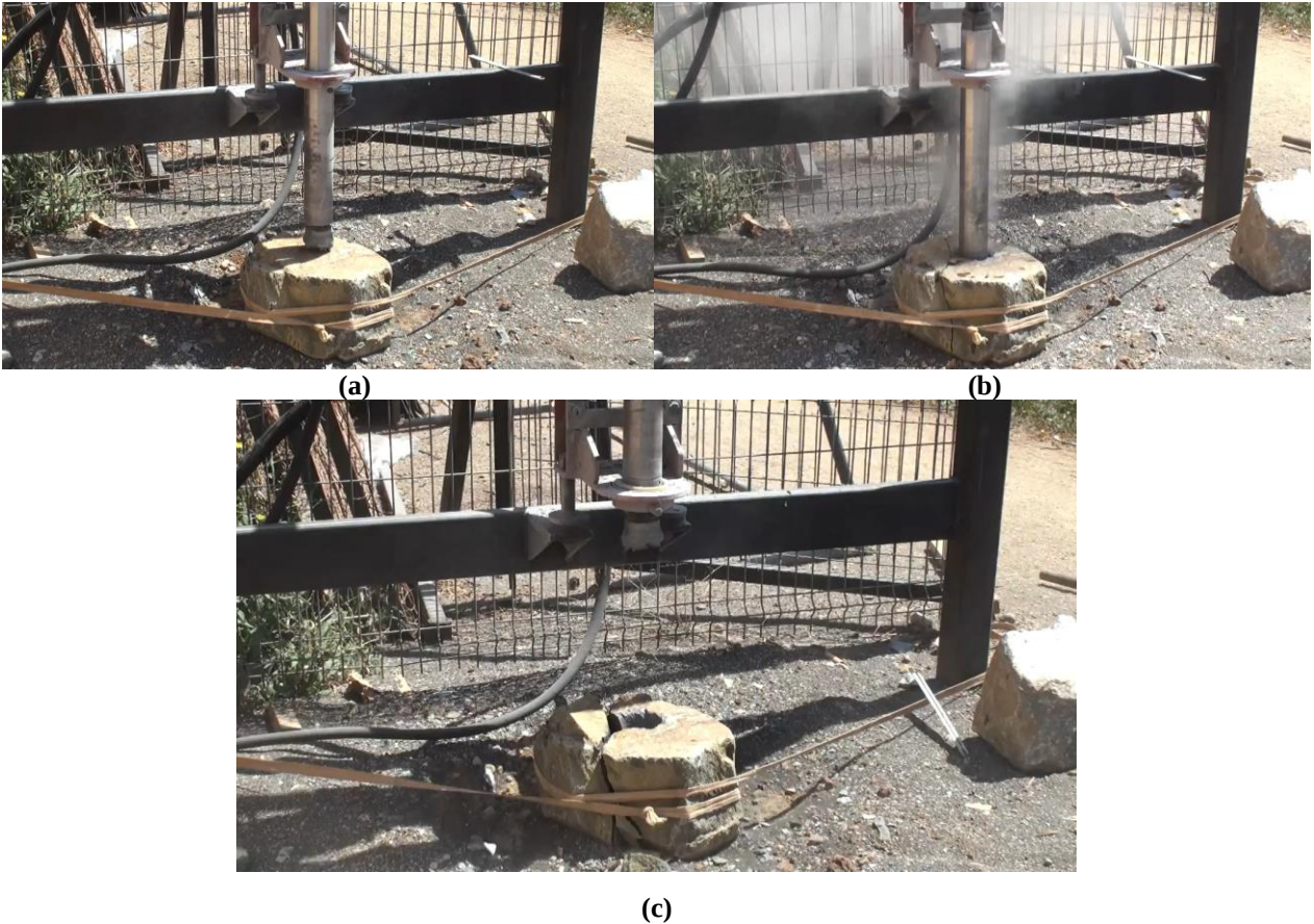
Figura 4.8 Perforación Roca Cantera Punta de Parra.
