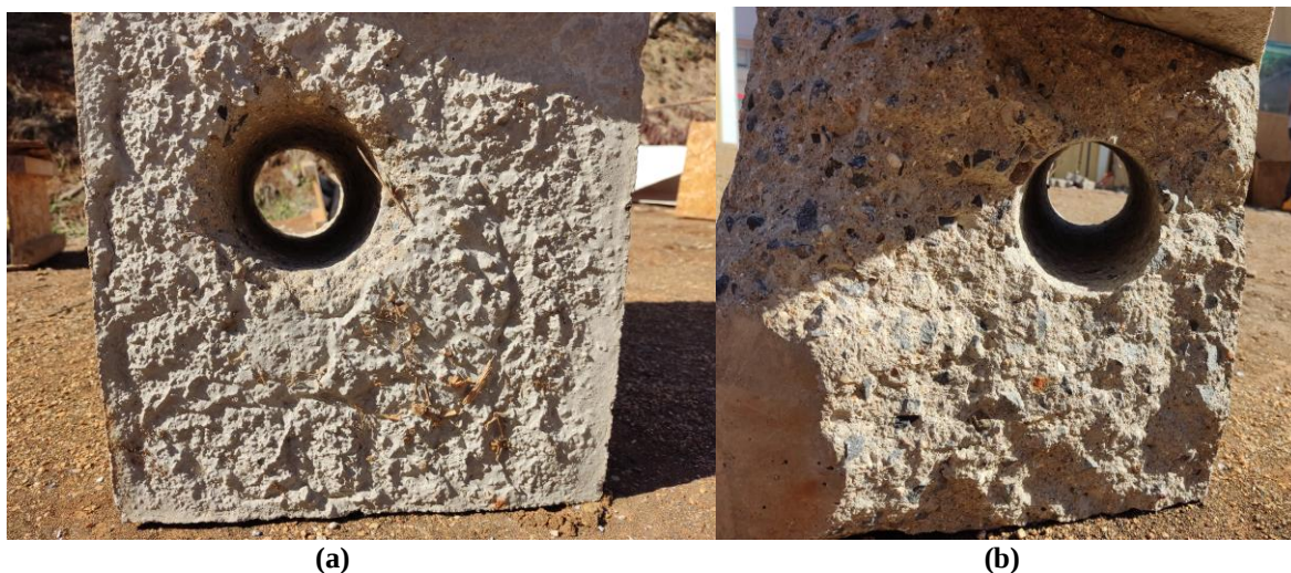
Figura 4.21 Muestra hormigón gravilla después de la perforación, prueba 4.
