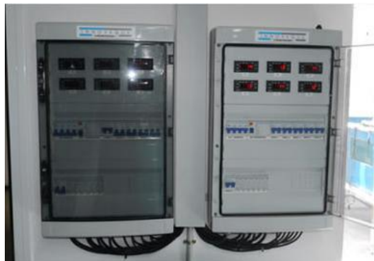
Ilustración IX. Cuadros de control de temperatura
