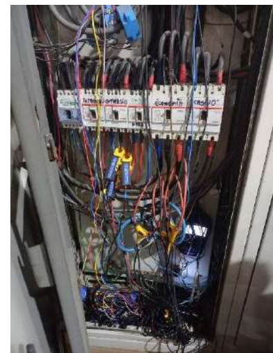
Instalación equipo Casino
