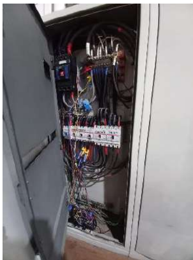
Instalación equipo Gimnasio
