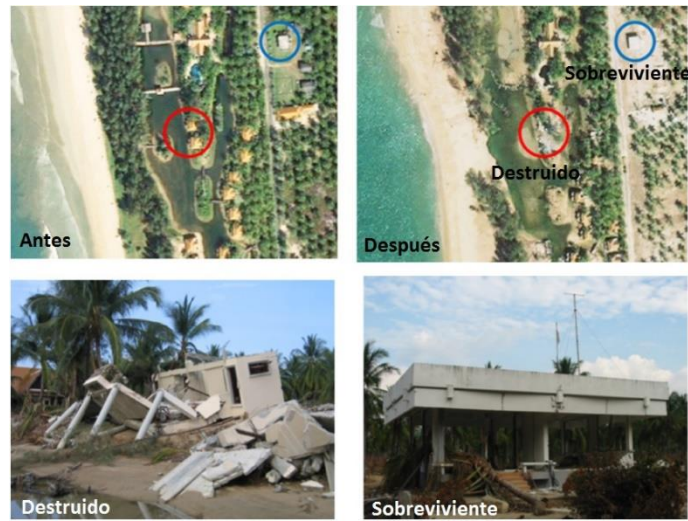
Figura 2.8: Niveles de daño por teledetección.
