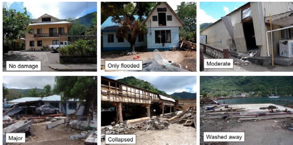
Figura 2.9: Niveles de daño mediante encuestas de campo (Gokon).
