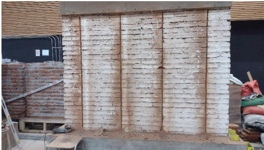
Figura 3: Muro con los surcos para la instalación de refuerzo.
