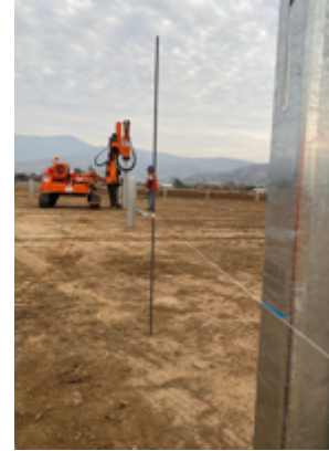
Figura 9: Instalación de hincas. Fuente: BMR SPA
