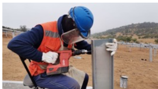
Figura 13: Fabricación de perforaciones y ojales. Fuente: Elaboración propia.
