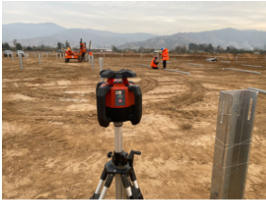
Figura 9: Instalación de hincas. Fuente: BMR SPA
