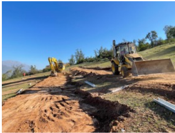
Figura 7: Confeción de terrazas PFV Gavardo. Fuente: elaboración propia.
