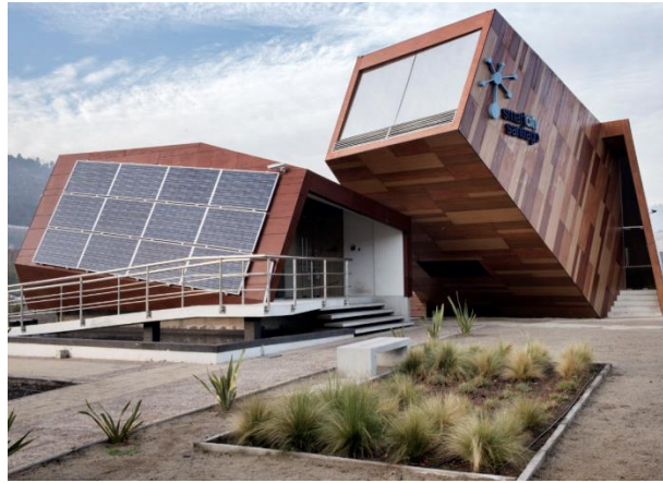
Figura 6. Edificio Smart Grid Huechuraba. Fuente. Enel-Pipartner Group.
