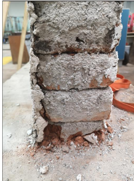
Figura 13: Falla por aplastamiento. (Fuente: elaboración propia).
