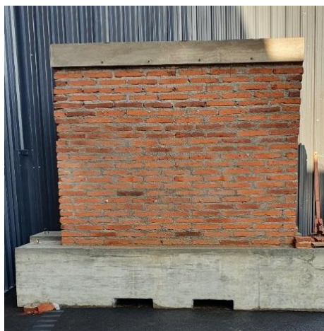
Figura1. Muro de ensayos construido con albañilería simple. (Fuente: Elaboración Propia)
