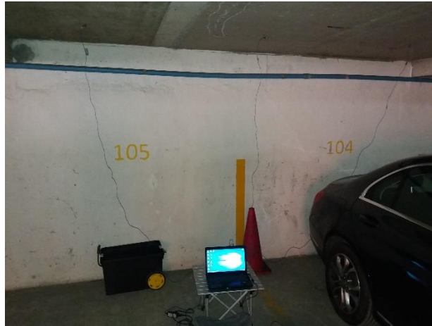
Figura 3: Instalación de equipos de medición.
