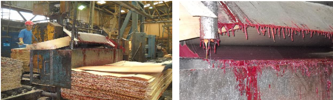
Figura 12: encoladora de rodillos, y su aplicadores
