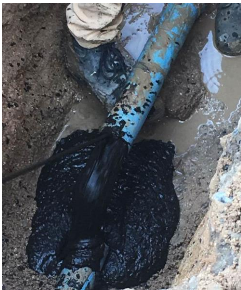
Figura 12 Limpieza mecánica para la extracción de la capa de sarro.
