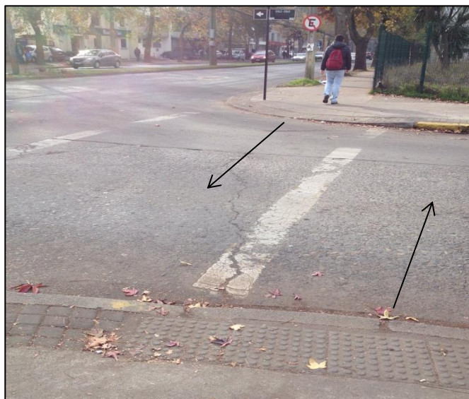
Figura 6-30: Rebaje no alineado con líneas de cruce peatonal. Chacabuco / Colo Colo. Sector 3.
