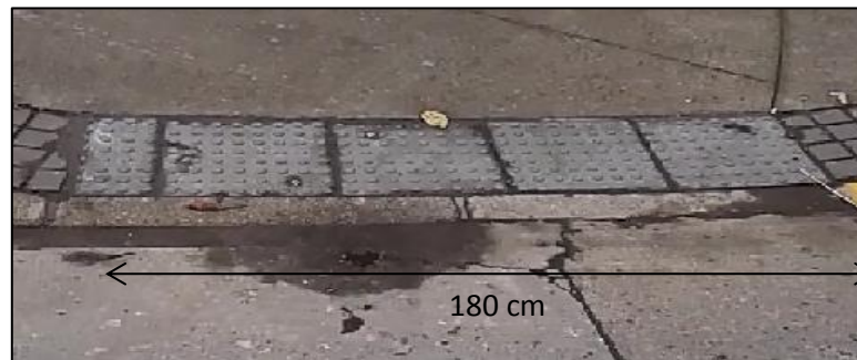
Figura 6-28: Rebaje peatonal con ancho mayor a 120 cm. Intersección Maipú/Angol, Sector 1.
