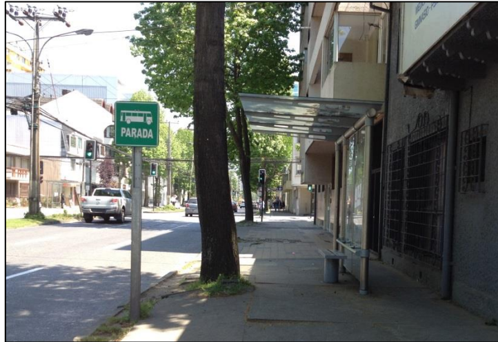
Figura 6-43. Paradero ubicado en zona de circulación peatonal. no se separa la zona de parada en paradero de la zona de circulación peatonal.
