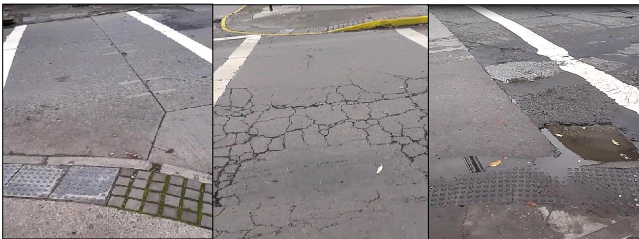
Zona de cruce en buen estado
