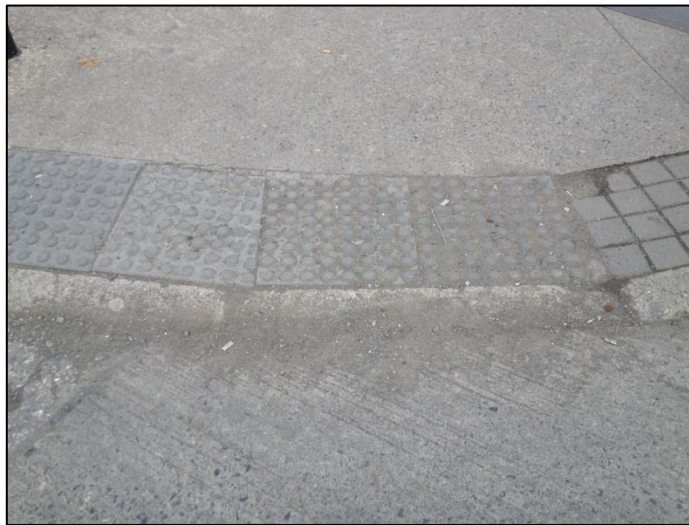
Figura 6-26: Rebaje peatonal con cota 0. Intersección Maipú/Angol, sector 1.
