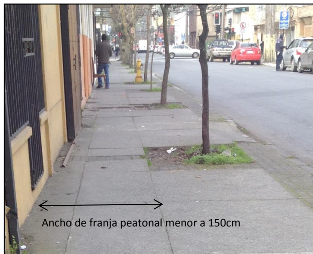
Figura 6-8: Esta vereda no cumple con un ancho recomendable de 150 cm a lo largo de toda la cuadra. Angol, entre San Martín y Cochrane, sector 2.
