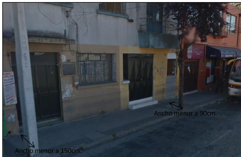
Figura 6-7: Esta vereda no cumple con un ancho recomendable de 150 cm a lo largo de toda la cuadra. Además en más de una zona no cumple con un ancho mínimo de 90cm. Tucapel entre Heras y Los carreras, sector 4.
