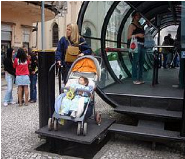
Plataformas mecánicas de subida y bajada a nivel en las Estaciones Tubo
