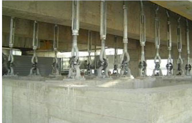
Figura 1: AMS edificio parque Araucano (SIRVE, 2012)
