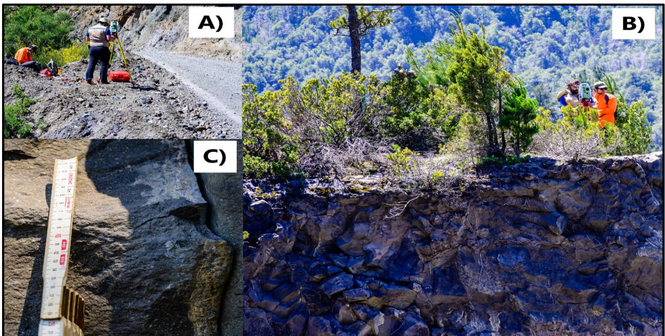
Figura 5.- A.B) Trabajo en terreno de la estación total para obtener topografía de la ladera en la primera visita. C) Obtención de los parámetros de las discontinuidades para calcular el Índice RMR en la segunda visita.
