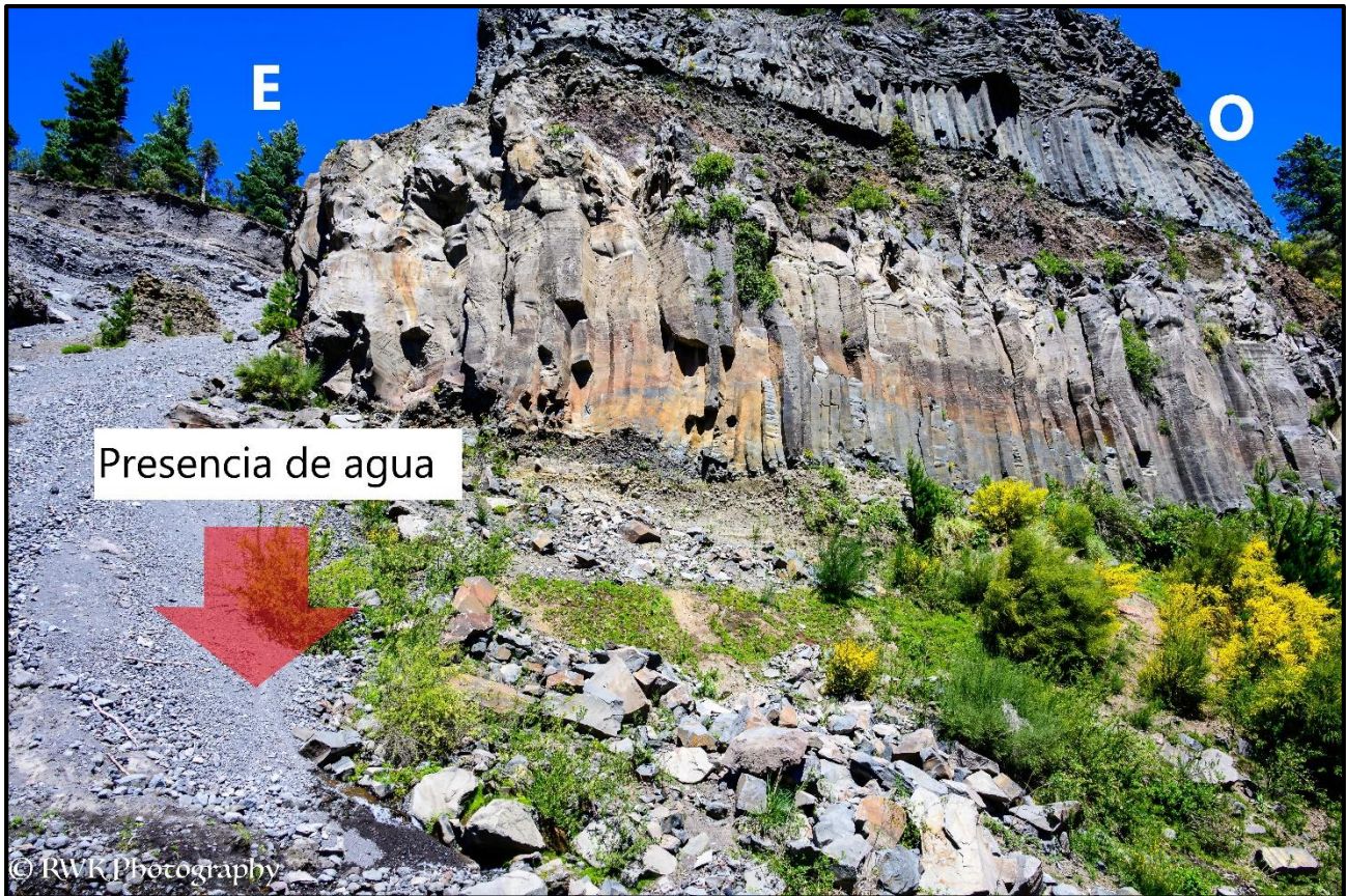
Figura 7. -Presencia de agua al costado este de la ladera de una antigua cascada y acumulación de bloques caídos en la zona de talus que además caen a la carretera.
