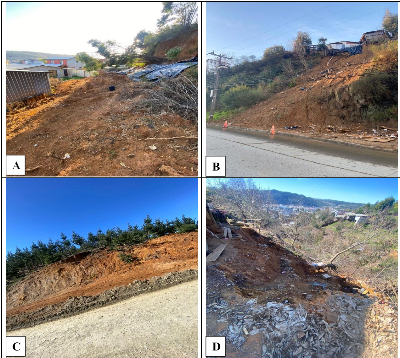
Figura 8: Zonas afectadas por las lluvias ocurridas entre el 10 y el 16 de junio de 2024. La Imagen A corresponde al punto 1, la Imagen B al punto 2, la Imagen C al punto 3 y la Imagen D al punto 4. Elaboración propia.
