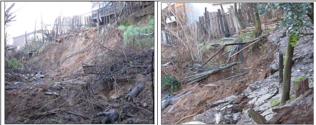
Figura 3: Se aprecia un desnivel generado por la remoción, con aproximadamente 2 metros de diferencia de cota, lo que evidencia la magnitud del deslizamiento que afectó a varios sitios del sector y destruyó al menos tres viviendas. Inspección de Sernageomin, 09 de junio de 2006, tres días posterior al evento (Ramírez, 2006).
