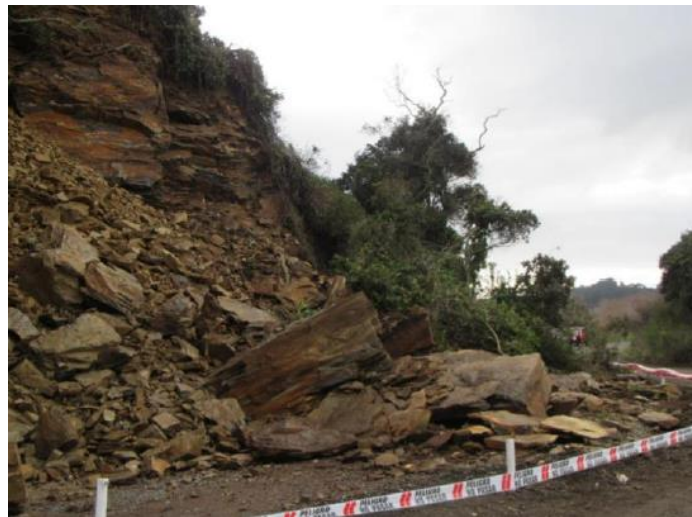
Figura 2: Remoción en masa por volcamiento en el interior del Parque Pedro del Río Zañartu, comuna de Hualpén, Región del Biobío, Chile. (SERNAGEOMIN, 2019).
