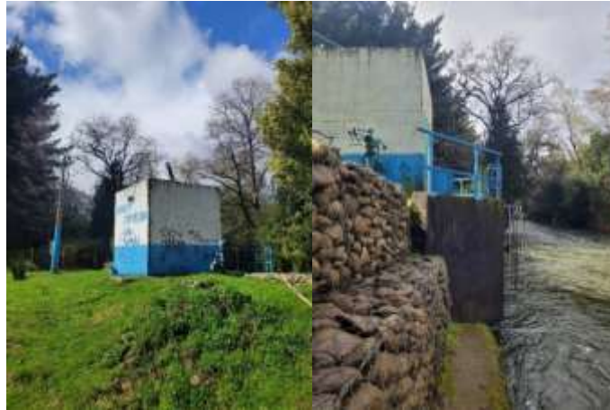
Fotografía 3. Ubicación captación de Agua Potable Rural (APR). Fuente: toma propia.
