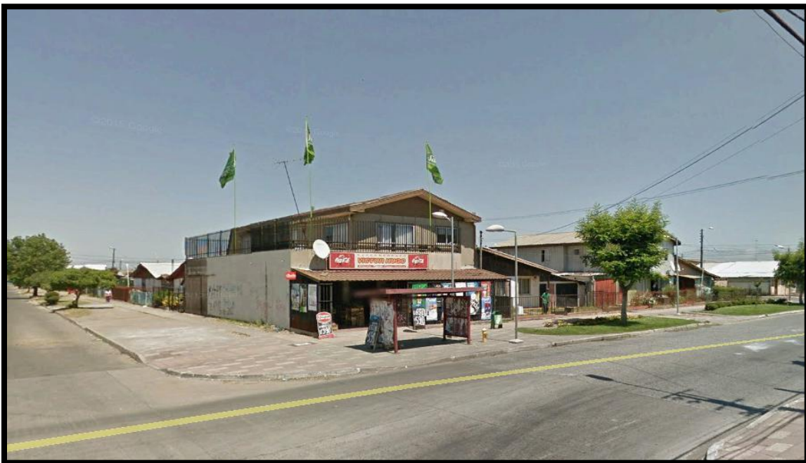
FIGURA 2-5: Vista frontal PC1, intersección Bremen con Alemania
