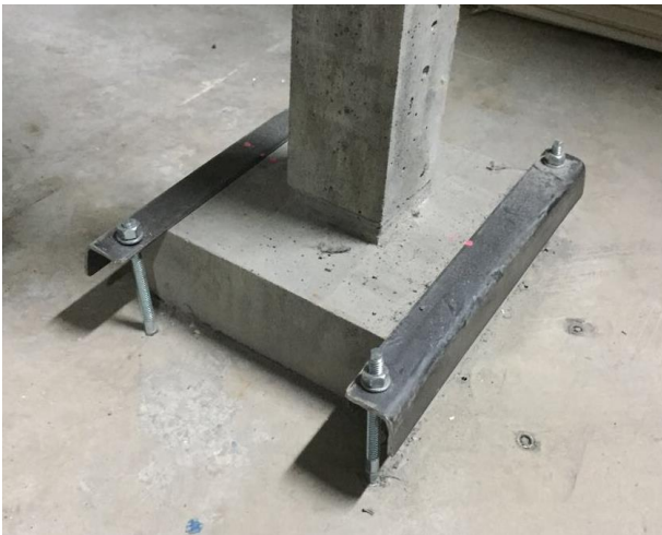
Fig. 11. Apoyo columna
