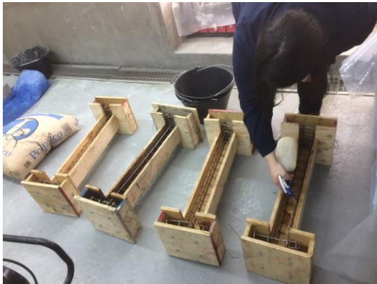
(a) Aplicación de desmoldante
