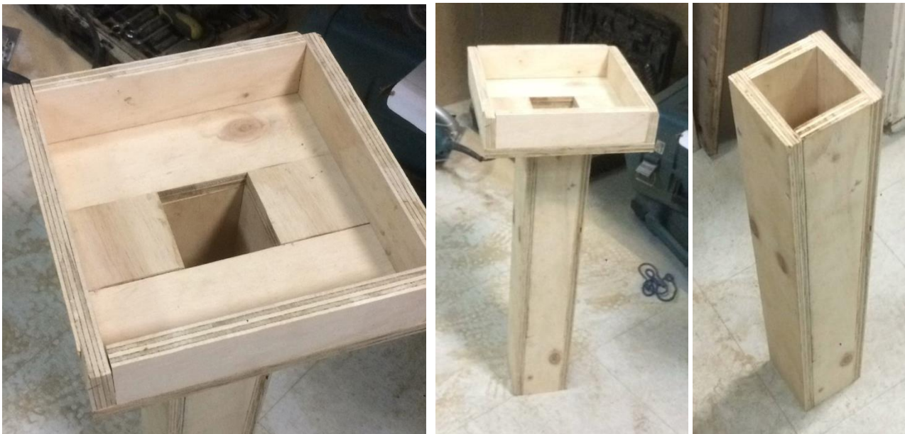
Fig. 5. Moldaje columnas
