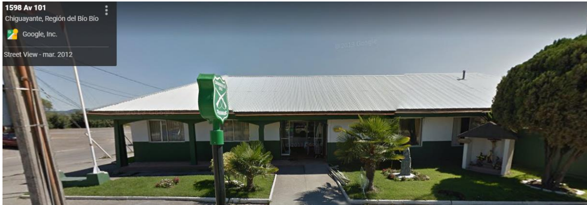
La subcomisaria de Chiguayante, obra ejecutada con personal del POJH, Cuando Chiguayante era parte de la comuna de Concepción.
