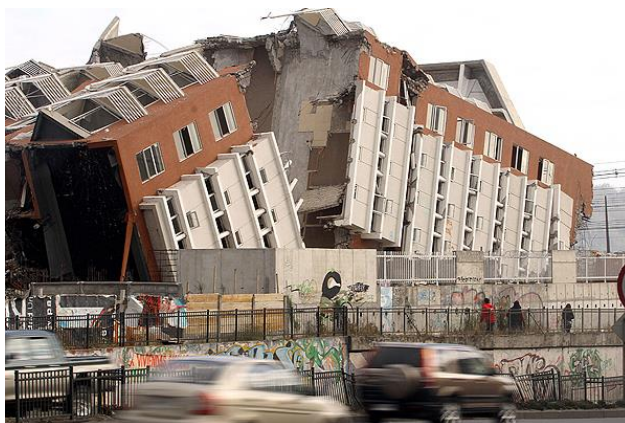
Figura 2.1: Edificio Alto Rio afectado por el terremoto en Chile del 27 de febrero de 2010.
