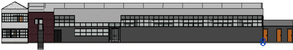
Figura N°6: Laboratorio Geología, Orientación Sur Fuente: Elaboración propia
