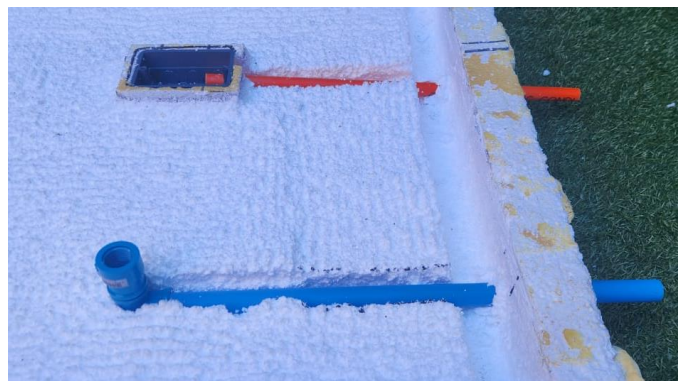
Figura 16: Panel de Poliestireno Expandido fresado y canalizado 2 Fuente: Elaboración propia.
