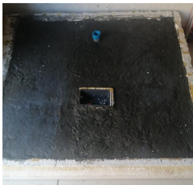
Figura 17: Vaciado de GRC sobre molde de poliestireno expandido Fuente: Elaboración propia.
