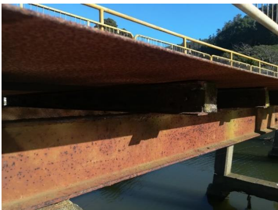
Fig.5: Unión viga secundaria a principal (izquierda)-Apoyo (derecha)
