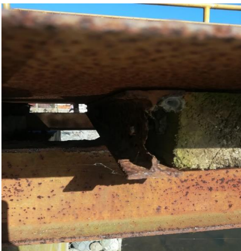
Fig.7: Corrosión en vigas principales y secundarias
