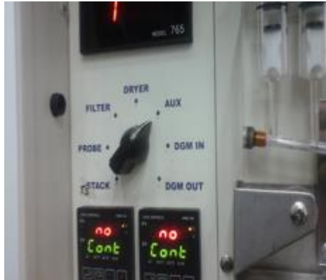
Fig. 4: Válvula de la base de control que indica las diferentes temperaturas del ensayo (Imagen obtenida del Laboratorio Área Combustibles CCP y Certificación de Productos, CESMEC S.A. Empresa BUREAU VERITAS. Concepción, Chile)
