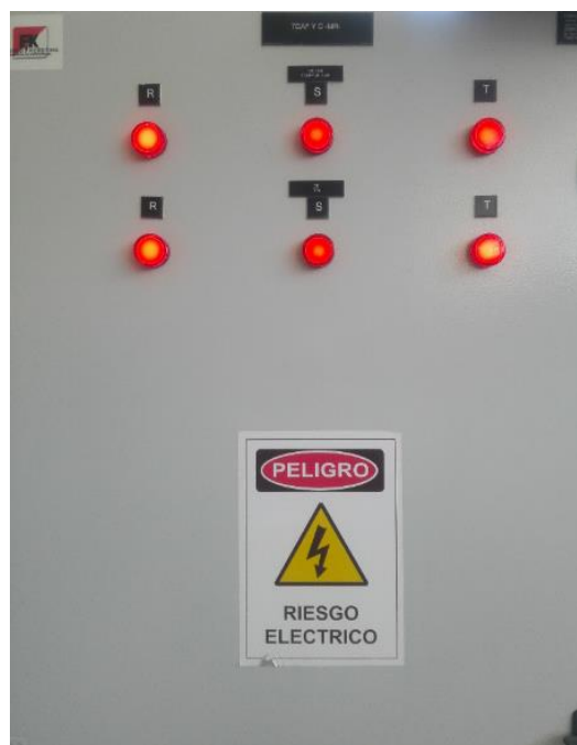
Fig. 5.10 Vista exterior TDAFyC“MR”. Fuente: Elaboración propia
