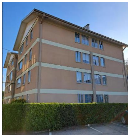
Figura 4.2: Fotografía actual Edificio de HA. Fuente: Elaboración propia. 2023.
