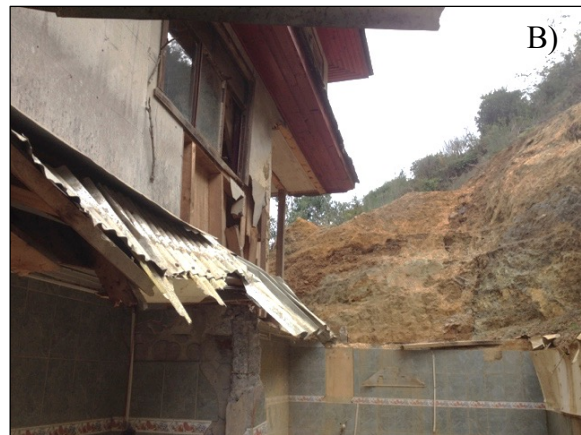
Figura 4: A) y B) Daños estructurales en la casa vecina por deslizamiento, Mayo 2016 (Fuente: Registro fotográfico personal).
