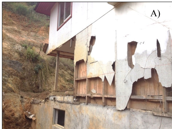
Figura 4: A) y B) Daños estructurales en la casa vecina por deslizamiento, Mayo 2016 (Fuente: Registro fotográfico personal).
